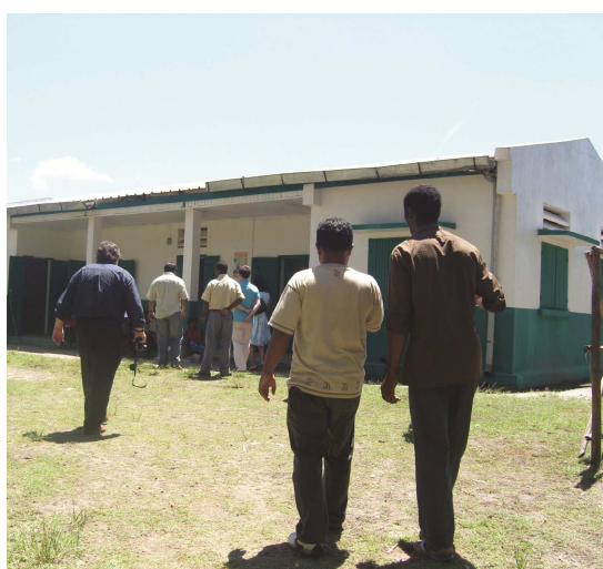
EPP nouvellement construite CR Ampasy, Région Anosy
